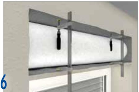
6 Fissare l'isolamento (utilizzare un morsetto ad espansione).
