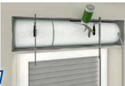
7 Fissare e rendere a tenuta i pannelli isolanti con schiuma per montaggio a bassa espansione alla battuta e nelle zone di giunzione.
